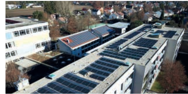
Sauberer Strom für den Schulkomplex am Gernerplatz
